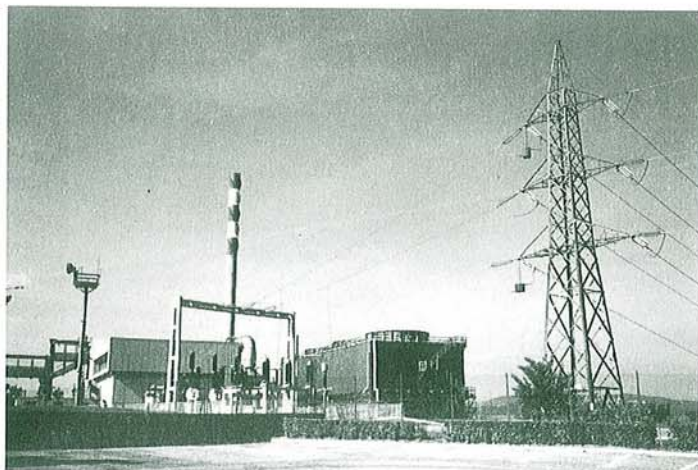
Abb 1: 20-MW Kraftwerk Travale-Radicondoli, Larderello, Italien
