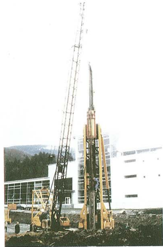
Abb. 9: Einbau eines Bewehrungskorbes mit HDPE-Wärmetauscherrohren an der Baustelle Medienhaus Vorarlberg, Schwarzach (Februar 1995)
